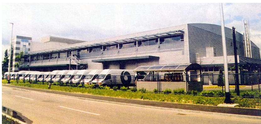
Pogled na građevinu s jugoistočne strane
