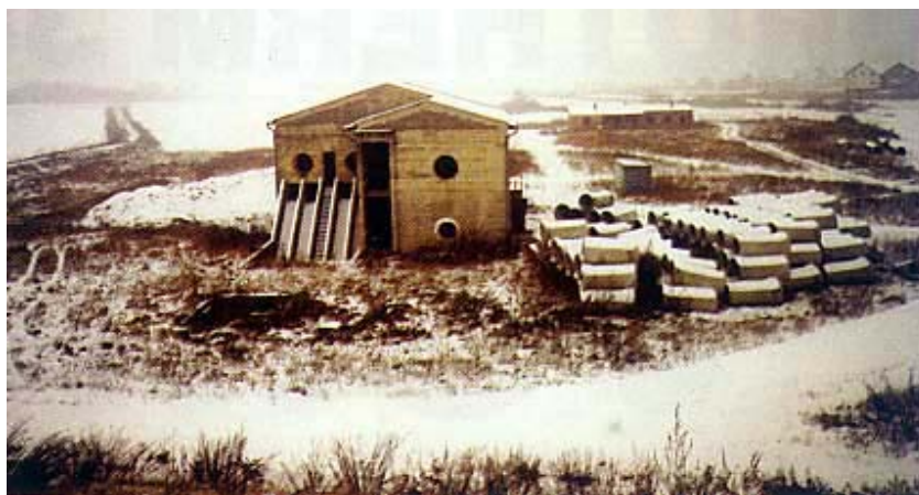
Gradilište uređaja za pročišćavanje
