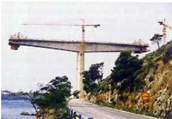
Slika 16. Konzolna gradnja prednapetog sklopa
