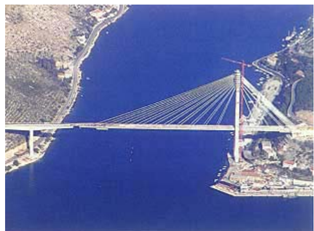
Slika 19. Most tijekom montaže posljednjeg segmenta čeličnog sklopa (montiran je jedan od dva glavna nosača
