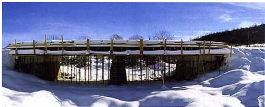
Gradilište mosta preko Suvaje zimi
