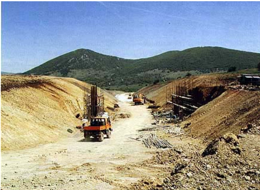
Radovi na priključnoj cesti na D1 s obilaznice Udbine
