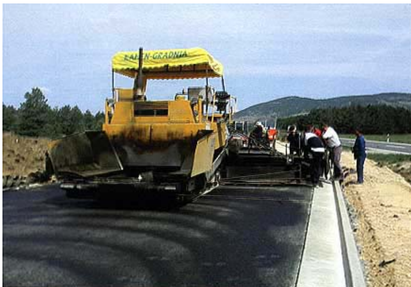
Početak asfalterskih radova
