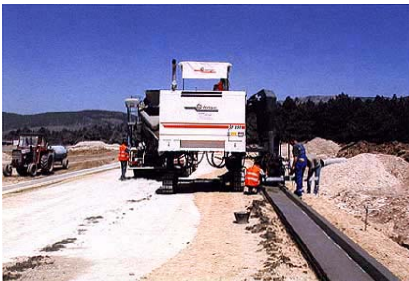
Ugradnja betonskih rubnjaka
