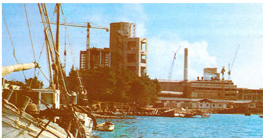
Tvornica cementa pokraj Splita
