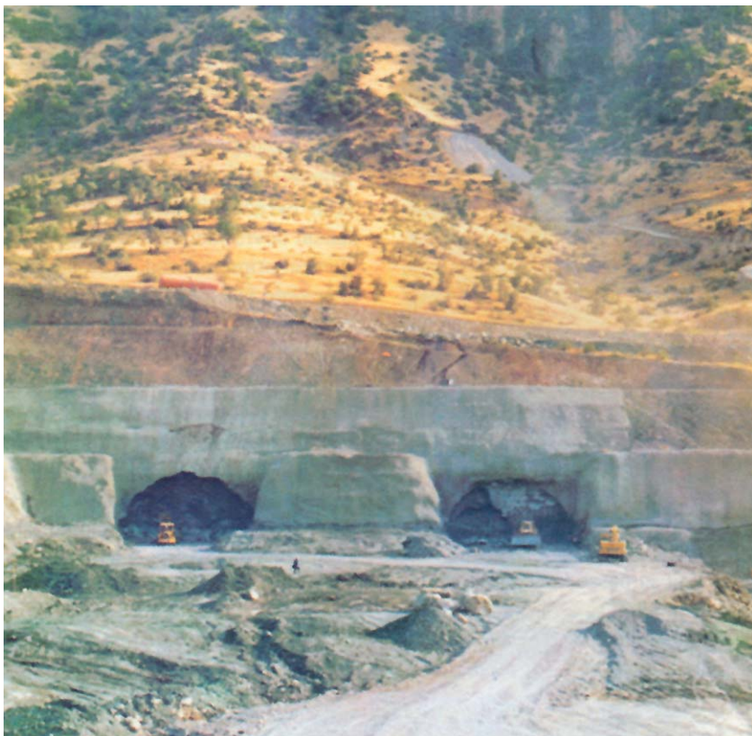
Dio gradilišta na HE Bekhme
