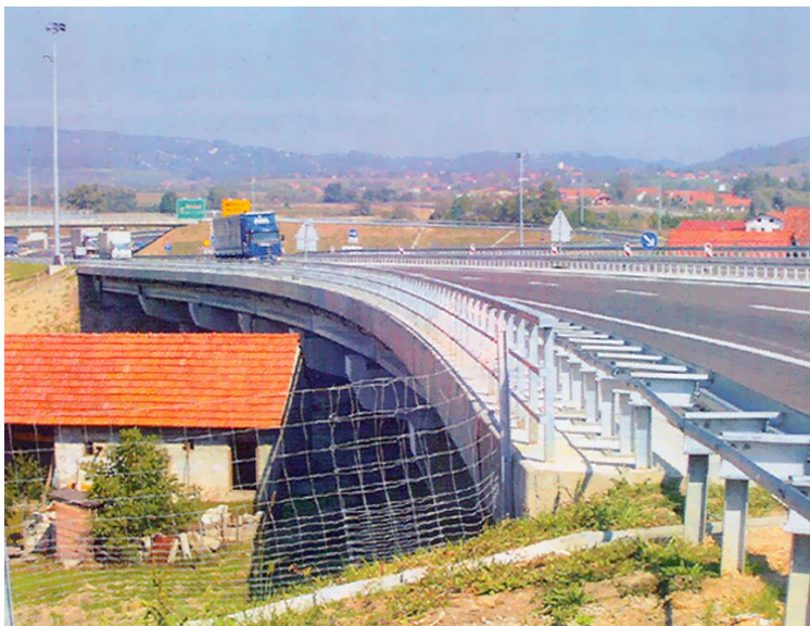
Slika 1. Pogled na vijadukt Moždenec
