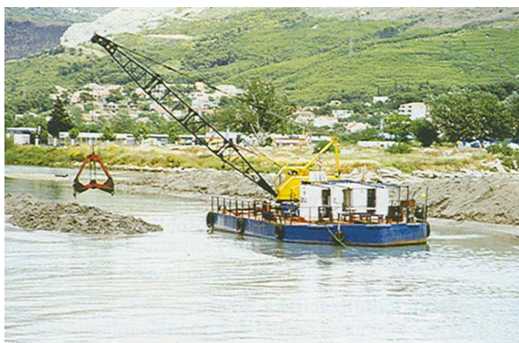
Slika 9. Izvođenje radova na morskoj dionici podmorskog ispusta u Stobrečkom zaljevu
