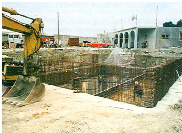
Slika 2. Izvođenje radova na crpnoj stanici Duje
