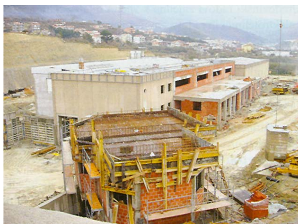
Slika 6. Gradilište objekata uređaja za pročišćavanje otpadnih voda Stupe
