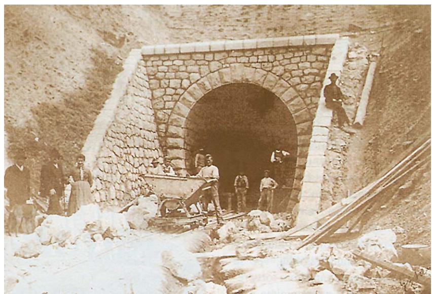
Gradnja tunela Gornja Rupotina
