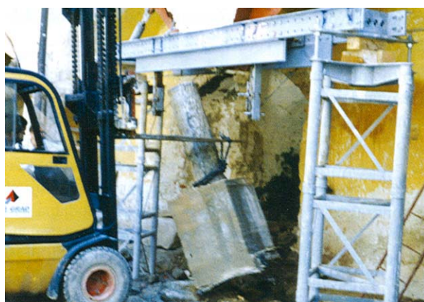
Slika 12. Uklanjanje srušenog kamenog stupa br. 8
