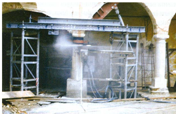
Slika 11. Rad dijamentno rezne ploče na stupu br. 3
