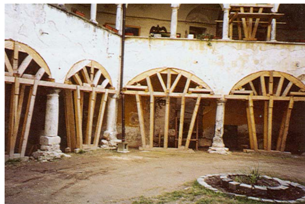
Slika 6. Snimak kamenih stupova i zatečene drvene podgrade
