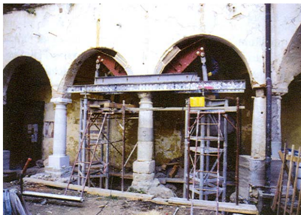
Slika 7. Preventivna sanacija najoštećenijih stupova; omotano tijelo stupa br. 5 i izvedeni betonski blok stupa br. 6-7
