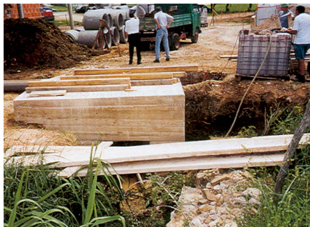
Slika 9. Radovi oko revizijskog okna na spoju dvaju kanala
