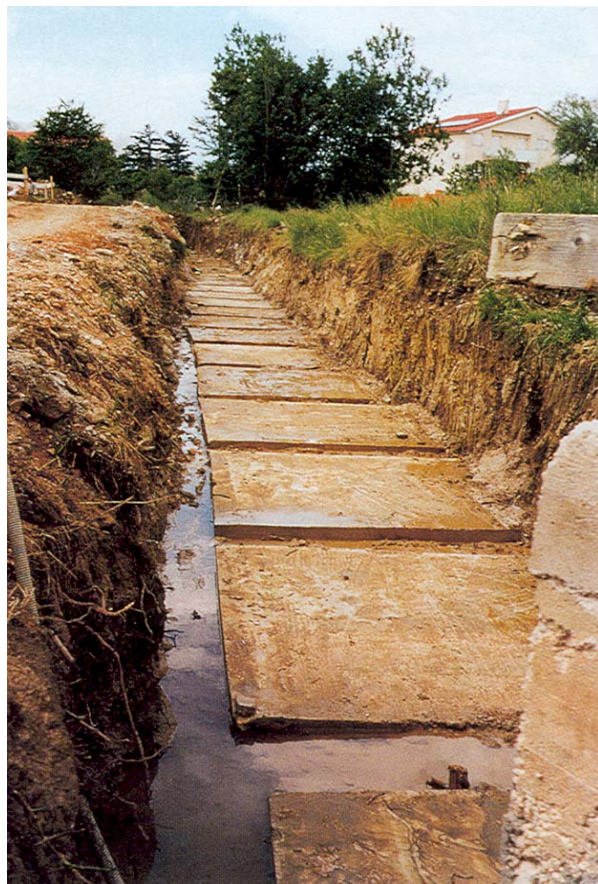
Slika 6. Iskop kanala i izrada betonske posteljice
