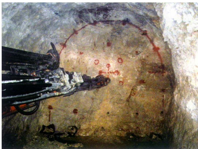
Početak proboja tunela
