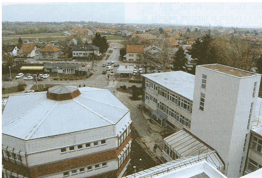
Pogled s krova na glavni ulaz
