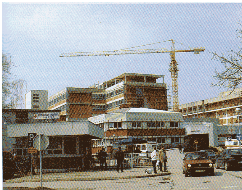
Glavni ulaz i novi paviljon u gradnji
