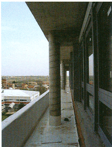
Detalj s gradilišta
