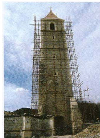
Završni radovi na obnovi zvonika
