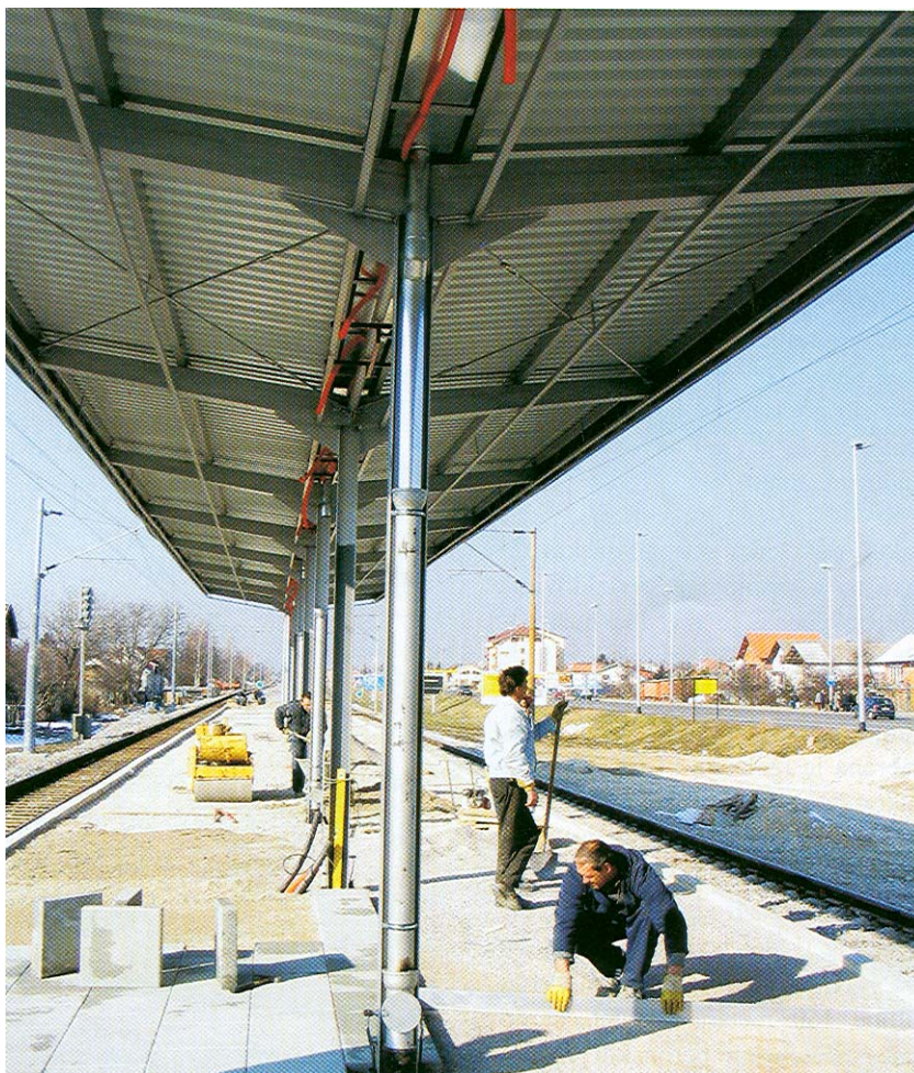
Polaganje betonskih opločnika na peronu
