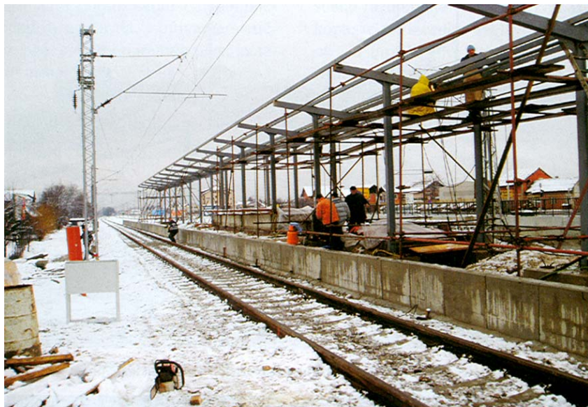
Montaža konstrukcije nadstrešnice
