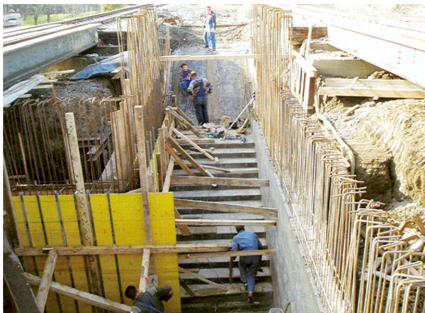
Montaža oplate i armature stubišta za izlaz na peron
