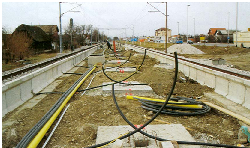
Trup perona s izvedenim temeljima nadstrešnice i položenim elektroinstalacijama
