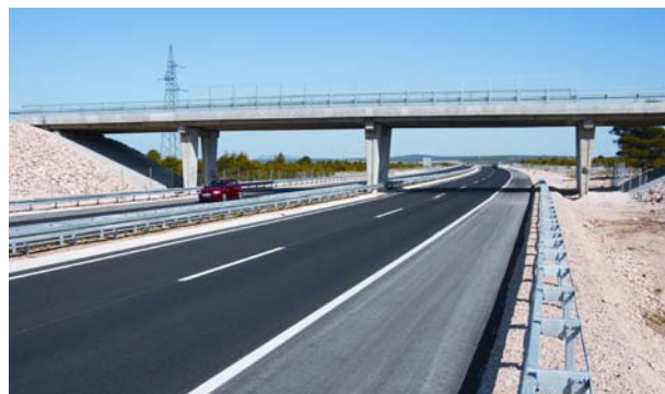
Slika 2. Dio autoceste Pirovac-Skradin s nadvožnjakom
