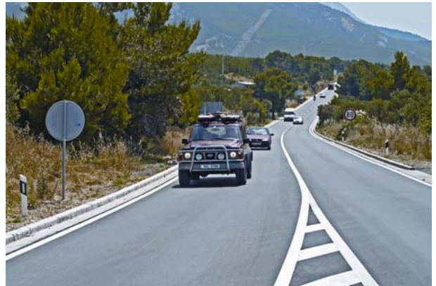
Slika 13. Dio ceste D-8 nadionici Baška Voda-Svetište Vepric
