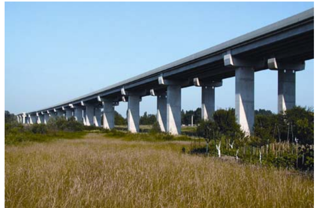
Slika 8. Vijadukt Drežnik na autocesti Rijeka-Zagreb
