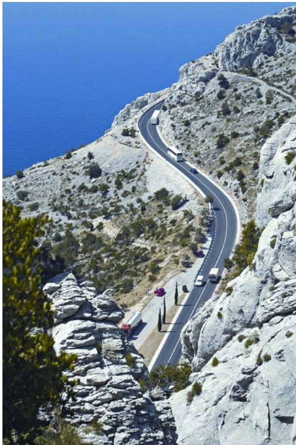
Slika 12- Dio rekonstruirane dionice Ruskamen-Dubci na cesti D-8
