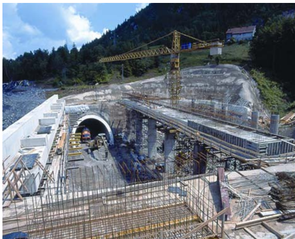
Slika 6. Nadstrešnica između tunela Javorova Kosa i Pod Vugleš u gradnji
