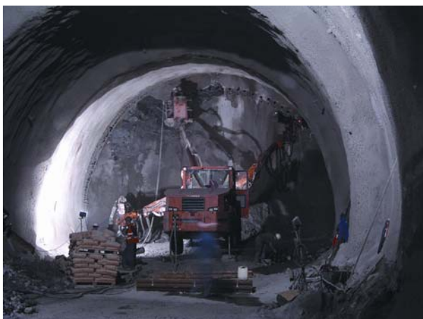
Slika 10. Izvedba obloge u tunelu Vrtilinovec na autocesti Zagreb-Goričan
