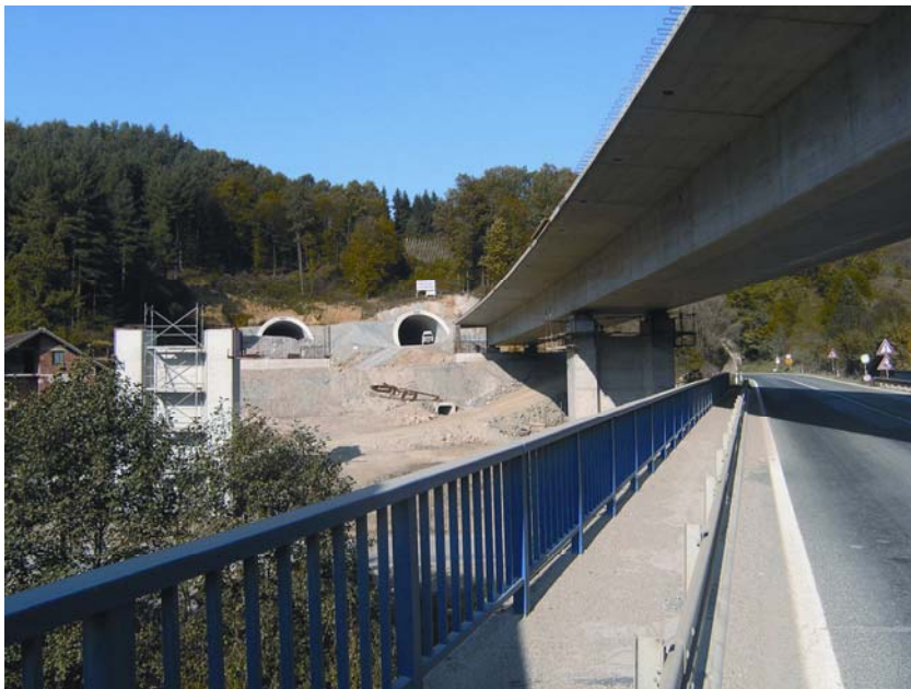
Gradilište vijadukta Mimarje i tunela Đurmanec
