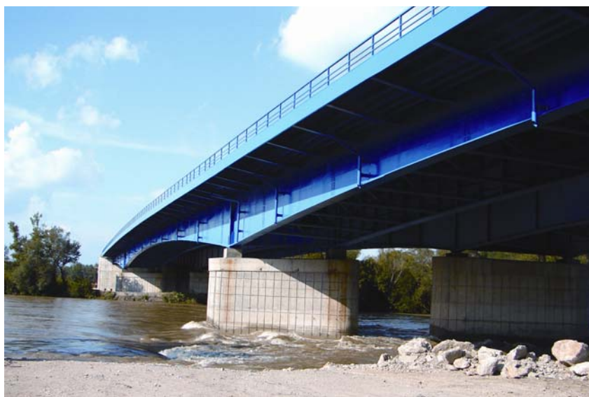
Pogled odozdo na izgrađeni dio mosta preko Save
