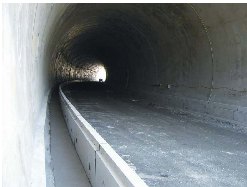
Radovi u tunelu Đurmanec
