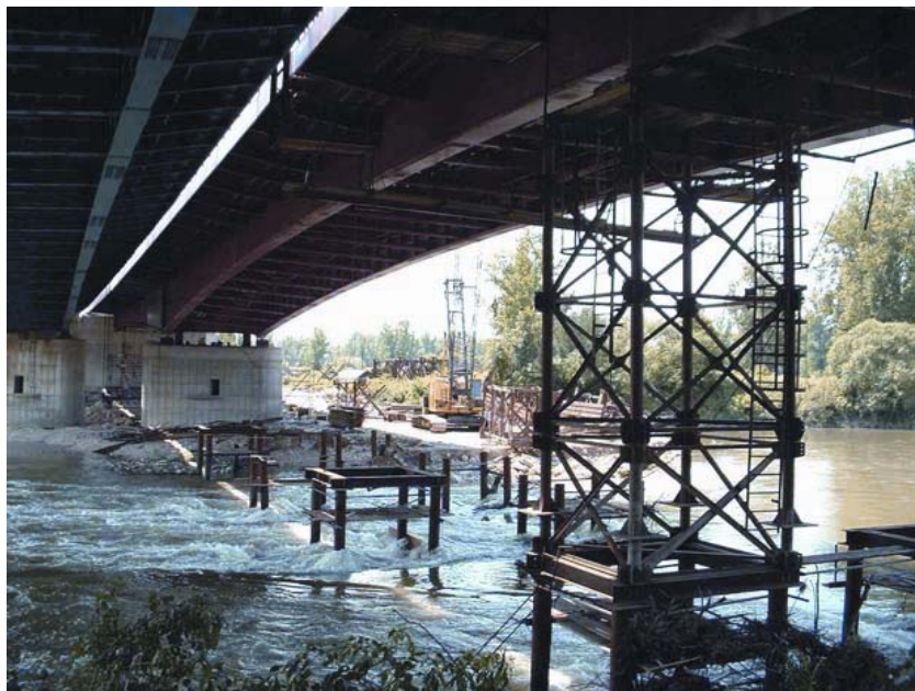
Gradnja kraka mosta preko Save
