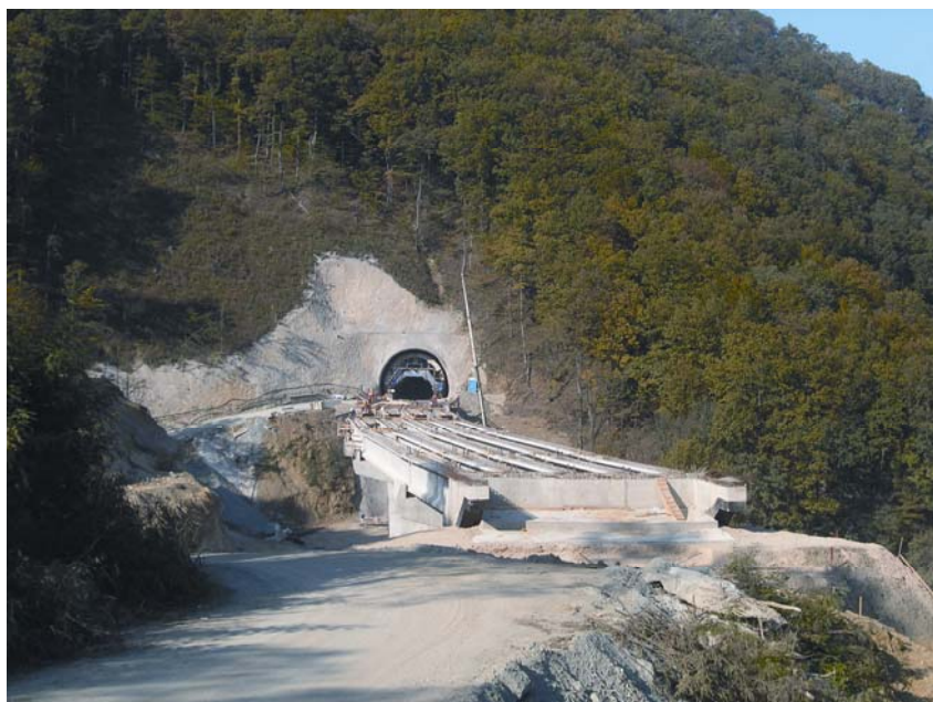
Gradilište vijadukta Šum i tunela Brezovica
