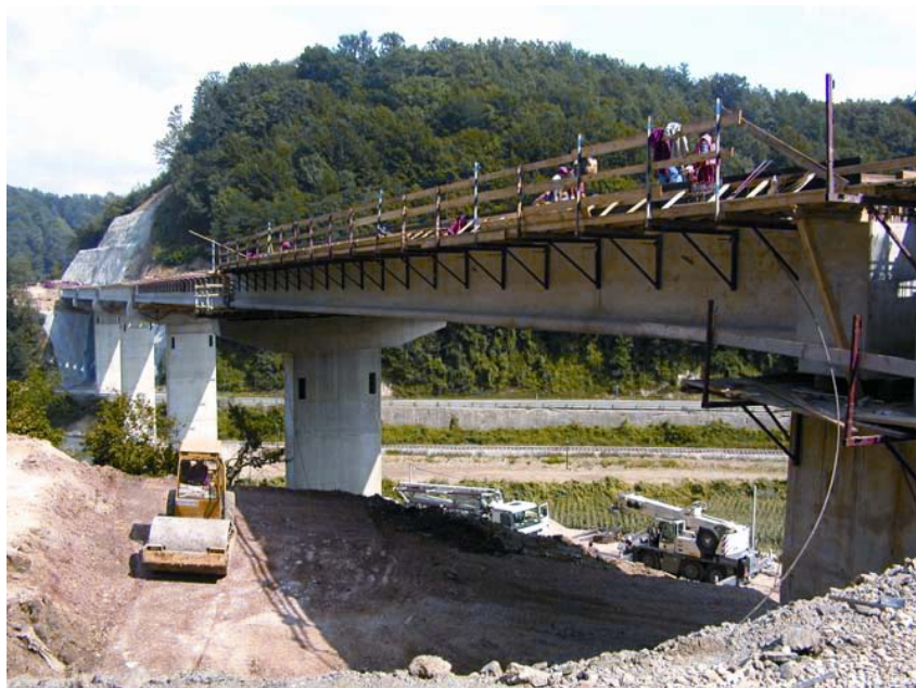
Vijadukt Puhi u gradnji
