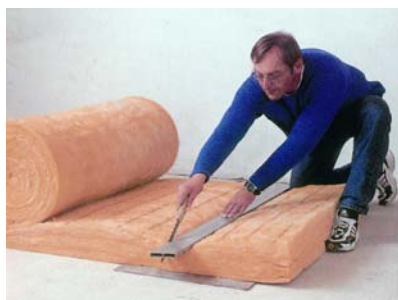
Slika 2. Rezanje i oblaganje stropa staklenom vunom
