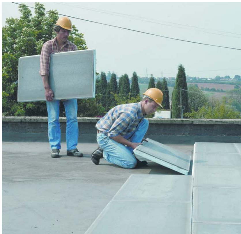
Slika 4. Izvedba izolacije ravnog krova ekstrudiranim polistirenom
