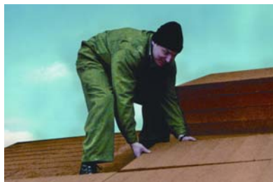
Slika 8. Polaganje izolacija od drvenih vlakana
