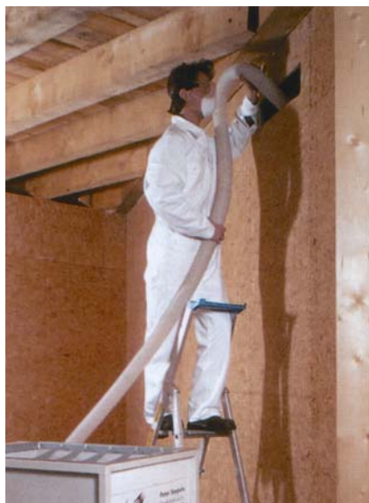
Slika 5. Ugradnja izolacije na osnovi celuloze
