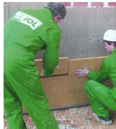
Slika 3. Oblaganje pročelja kamenom vunom
