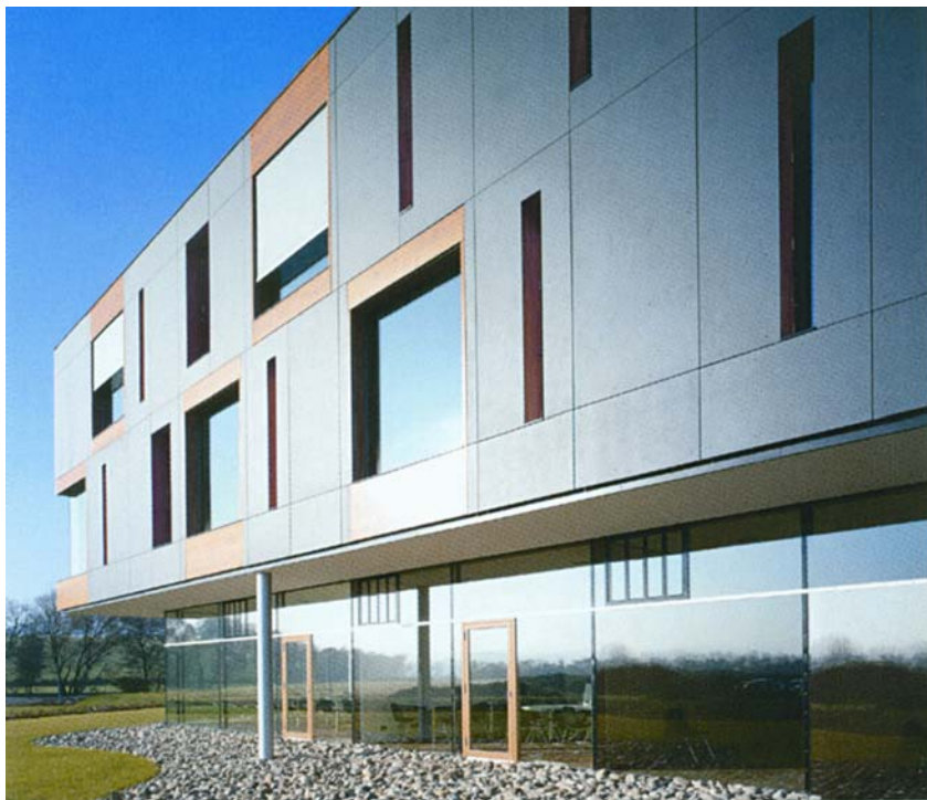
Slika 1. Zgrada tvrtke Pollmeier GmbH
