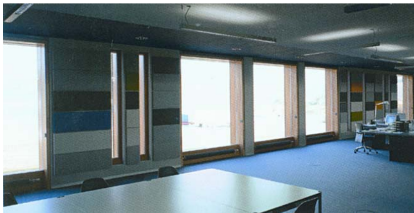
Slika 2. Unutarnja strana pročelja
