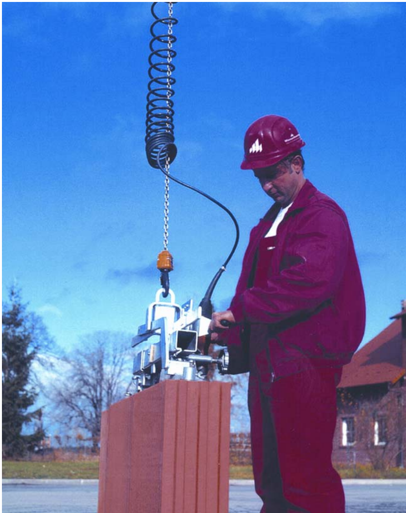
Slika 1. Jednostavno prenošenje plan-opeka T500 posebnim uređajem
