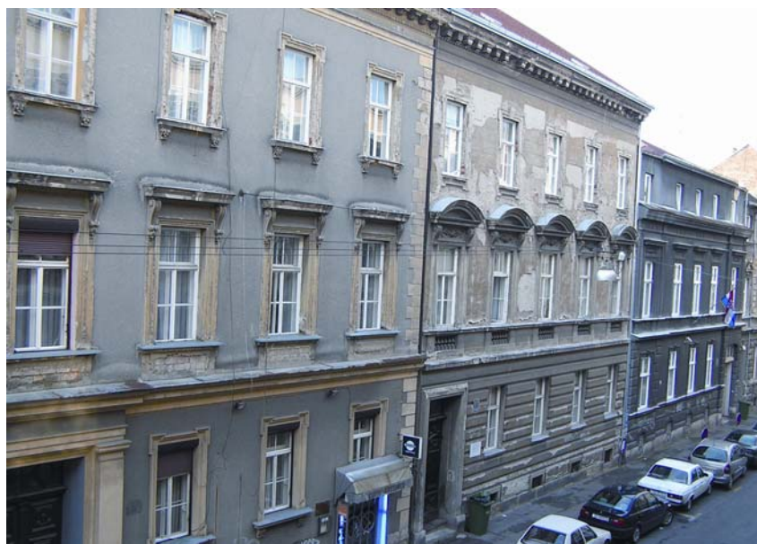
Slika 3. Obnovljeno pročelje zgrade U Berislavićevoj 10
