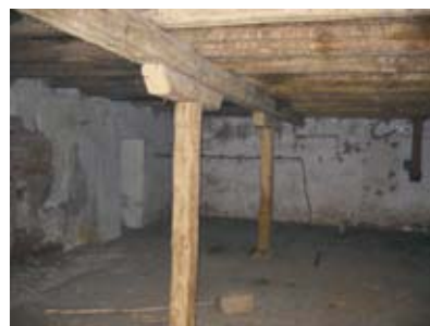
Slika 4. Drvena nosiva konstrukcija, mlin Belje
