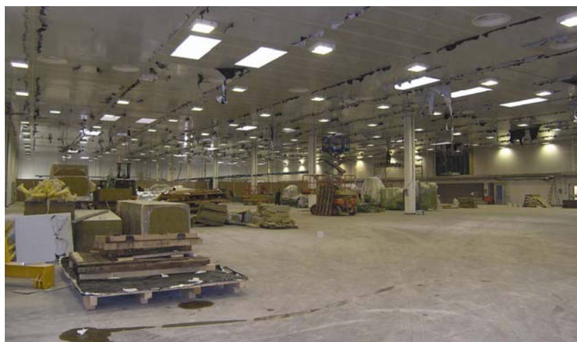
Montaža strojeva i opreme
