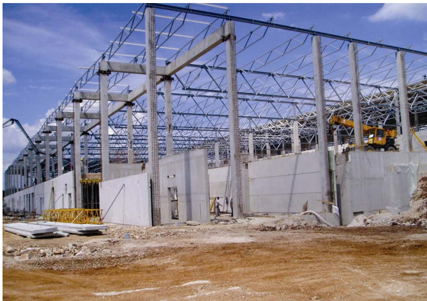
Ugradnja montažnih armiranobetonskih ploča na pročelju
