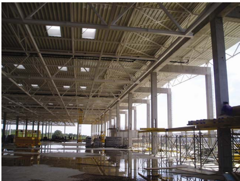
Pogled na montiranu čeličnu konstrukciju i pokrov
