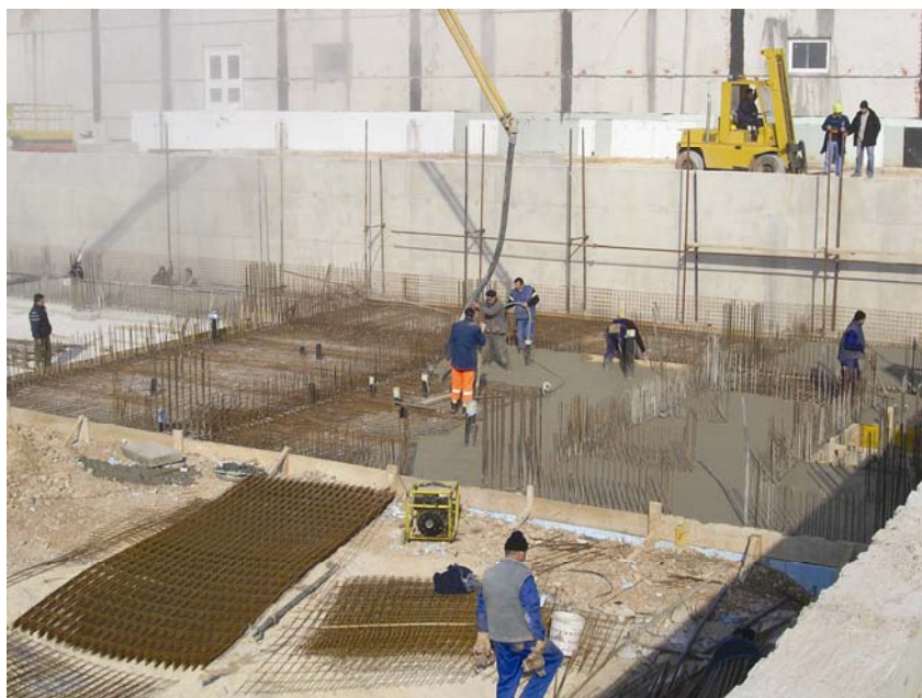
Početak gradnje upravne zgrade
