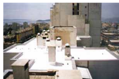
Izgled - poslije sanacije
