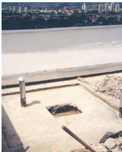
Bušenje slojeva krova zbog ugradnje odzračnika
