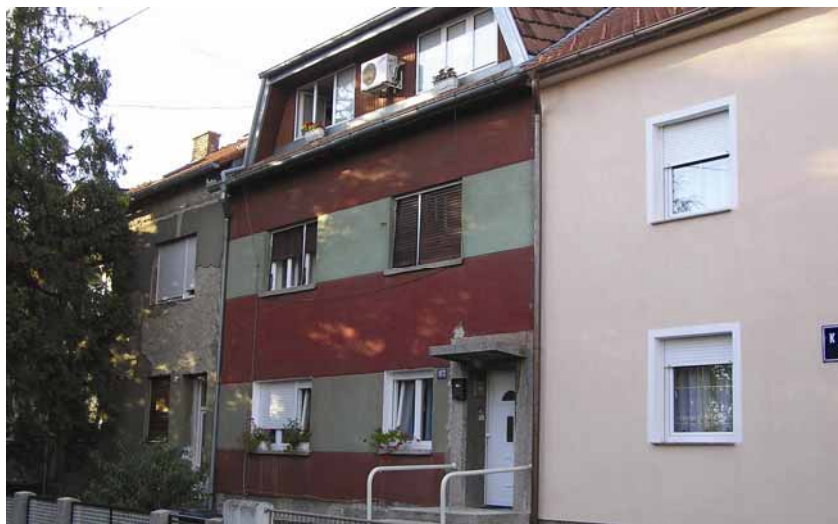
Prikaz nesaniranih i saniranih manjih oštećenja pročelja – otpadanje žbuke
