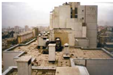
Izgled - prije sanacije
