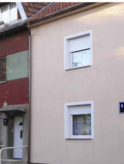
Prikaz nesaniranih i saniranih manjih oštećenja pročelja – otpadanje žbuke
