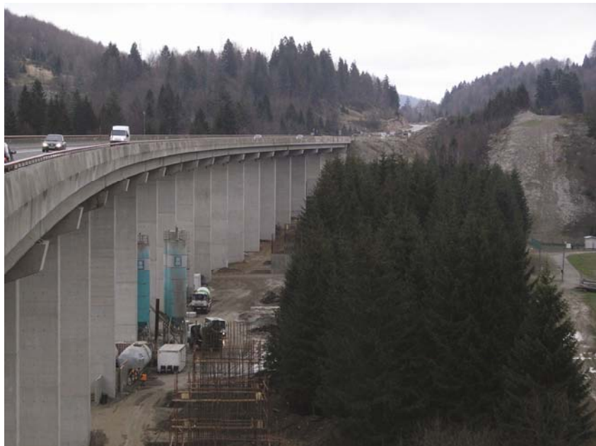
Gradnja stupova na vijaduktu Golubinjak
