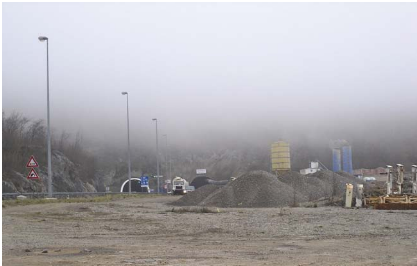
Betonska baza i separacija ispred tunela Tuhobić s riječke strane
