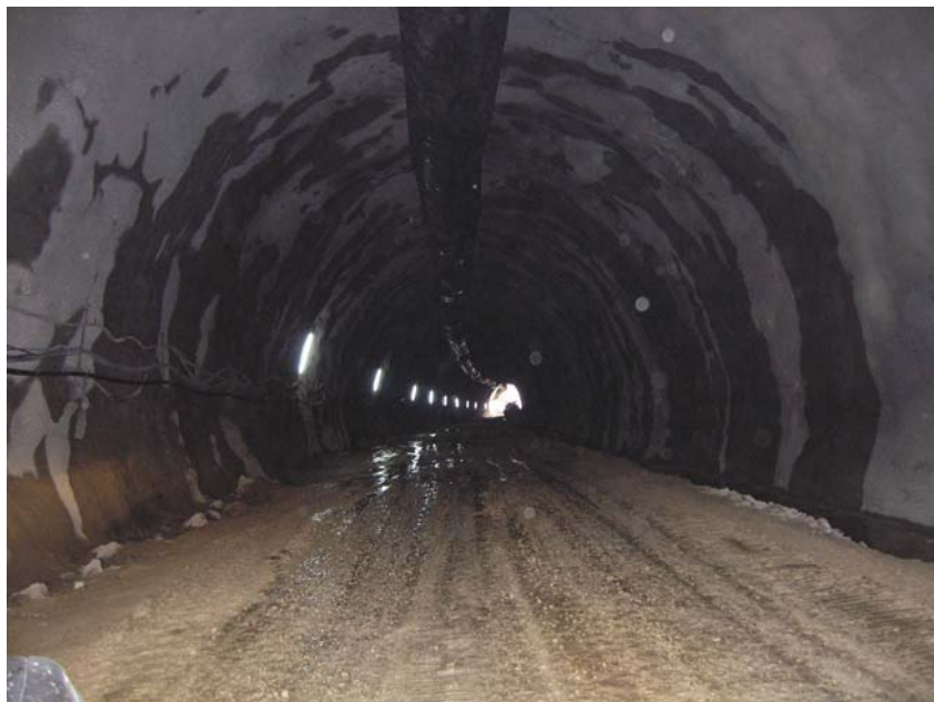
Pogled iznutra na portal tunela Tuhobić
