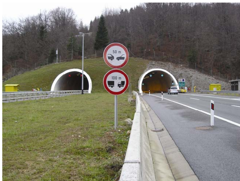
Druga cijev tunela Čardak (lijevo) puštena je u promet u ljeto 2006.
