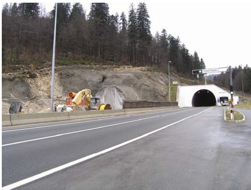
Proboj druge cijevi tunela Sopač. Platno na portalu najavljuje skoro miniranje
