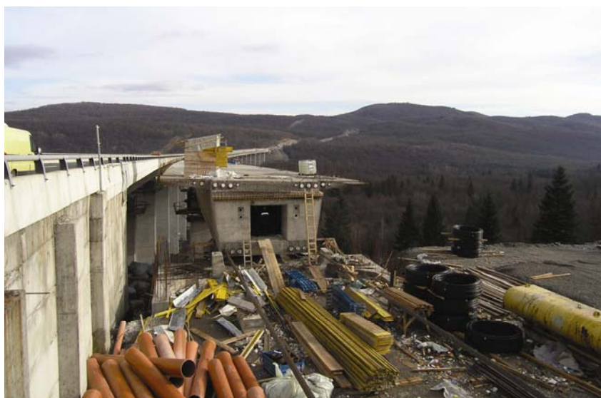
Gradnja drugog traka vijadukta Zečeve drage
