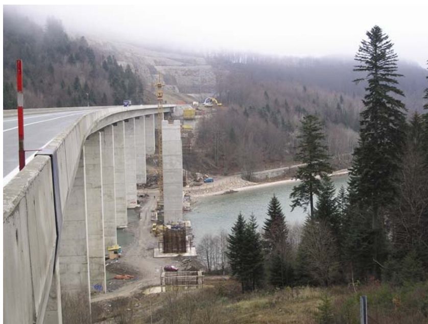
Gradilište mosta Bajer
