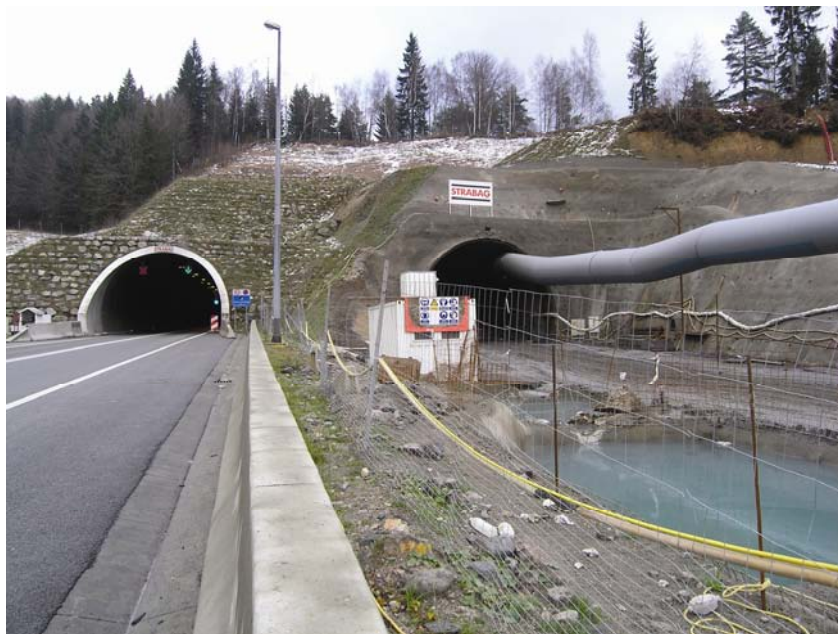
Proboj tunela Javorova kosa s riječke strane
