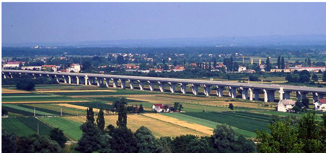
Vijadukt Dreznik na autocesti Zagreb - Rijeka
