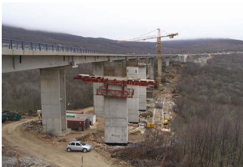
Radovi na drugom traku vijadukta Bukovo
