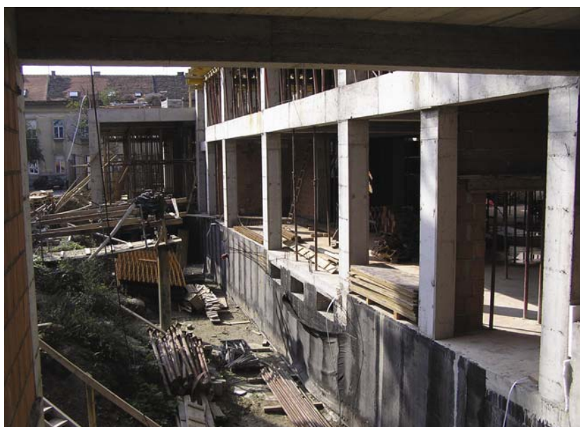
Izvedba radova u unutrašnjosti lamele 1
