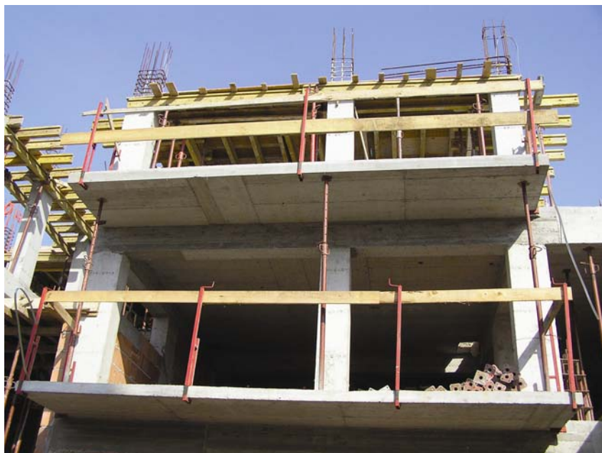
Detalj pročelja lamele 1 u gradnji
