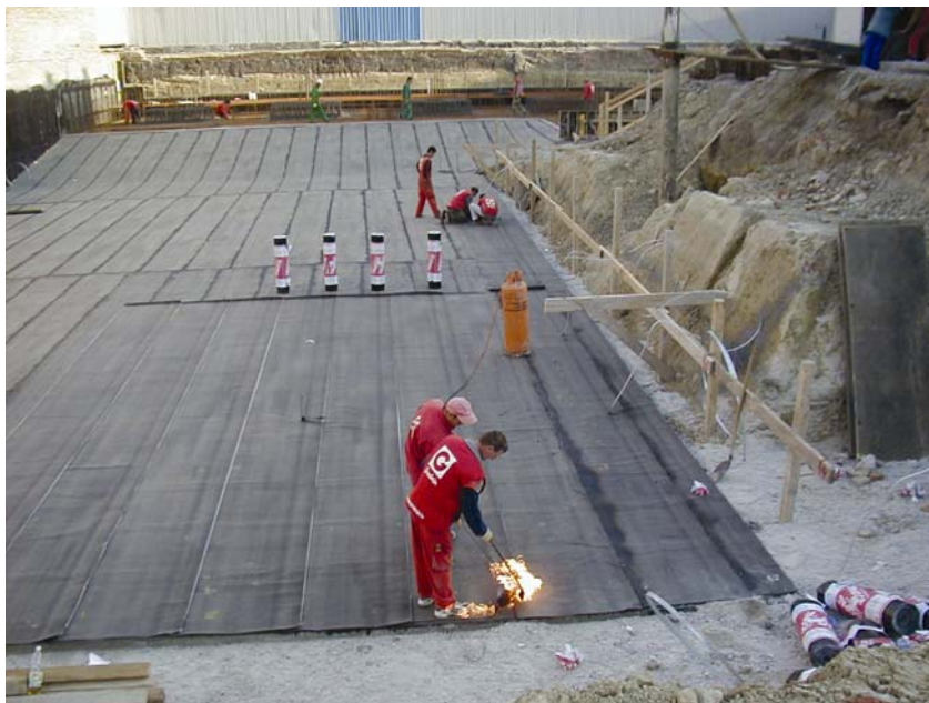
Izvedba horizontalne energetske instalacije
