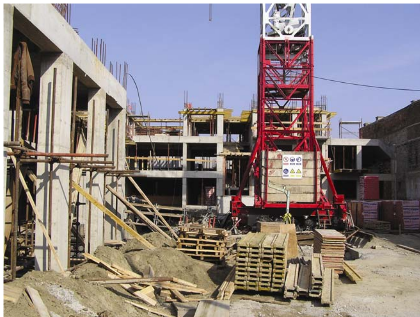
Pogled na gradilište dvorišnog dijela građevine
