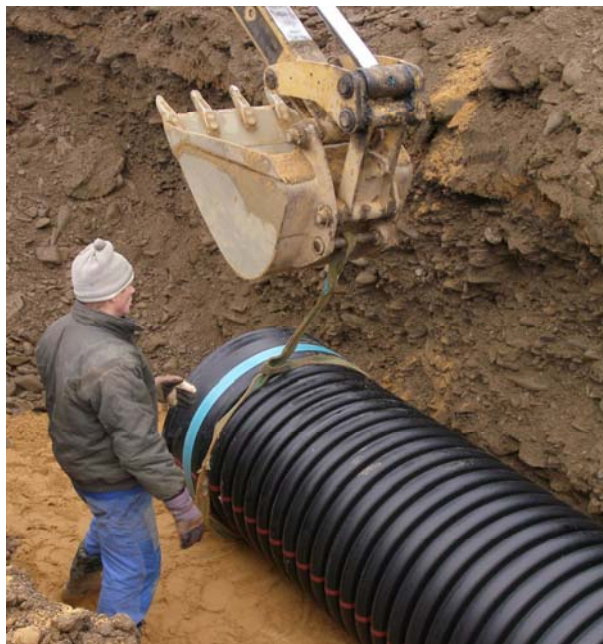
Slika 4. Ugradnja PP (polipropilenske) strukturirane cijevi, tip B
