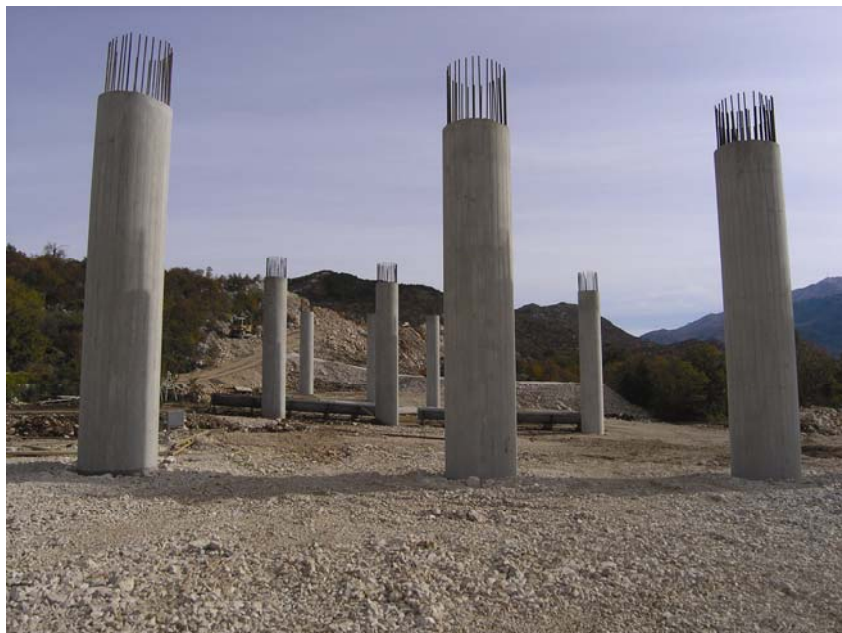
Stupovi vijadukta Mladine na autocesti Zagreb – Split - Dubrovnik
