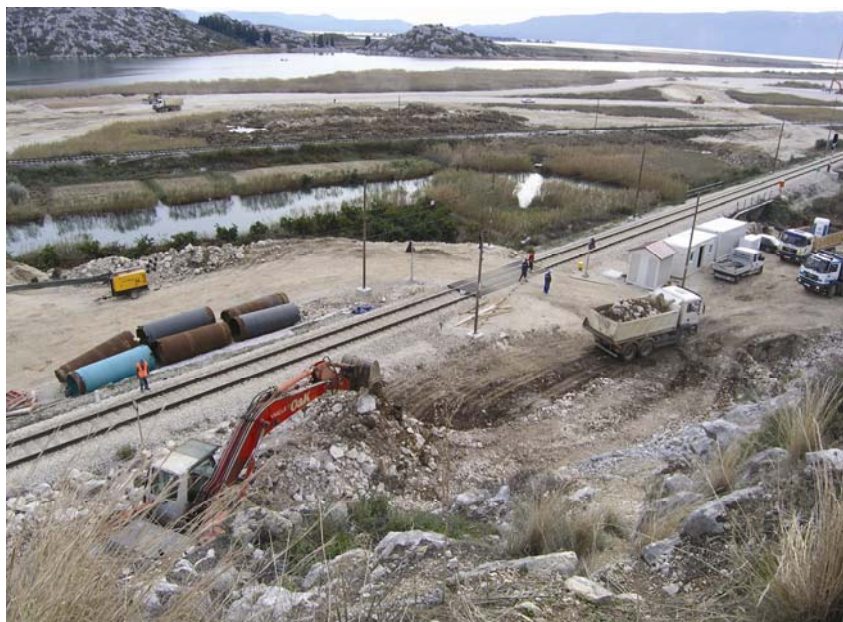
Radovi na budućem čvorištu Čevljuše
