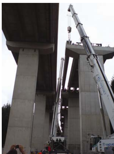
Izvedba drugog kraka vijadukta Golubinjak na autocesti Rijeka - Zagreb
