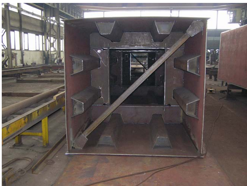
Pogled u unutrašnjost čeličnog nosača
