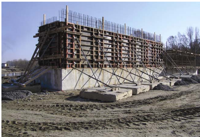
Priprema za betoniranje upornjaka na hrvatskoj strani
