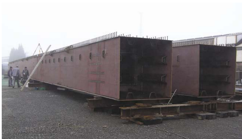
Izradeni dijelovi čelične konstrukcije
