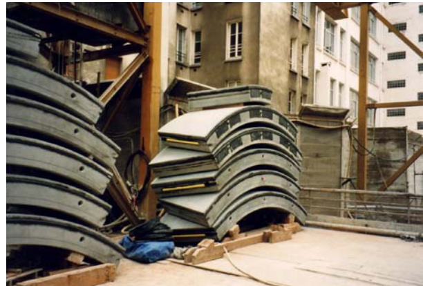
Slika 10. Prsten segmentne obloge spreman za spuštanje do mjesta montaže u tunelu
