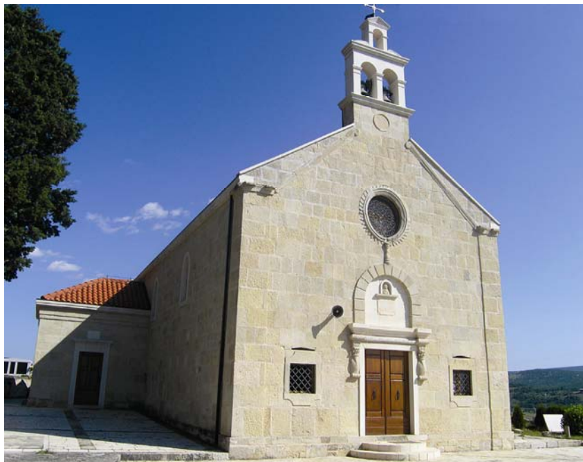
Obnovljena crkva Male Gospe u Gradcu
