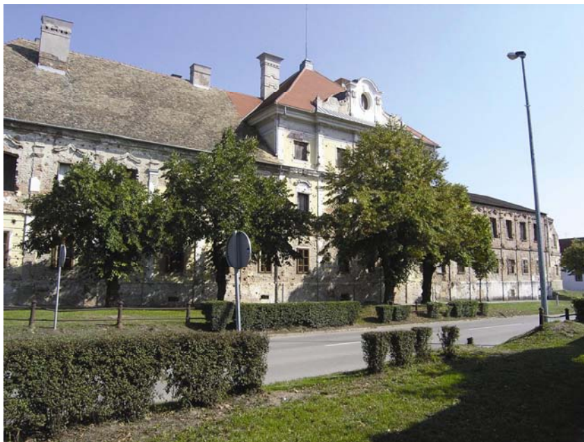
Pogled na sadašnje ulično pročelje dvorca Eltz
