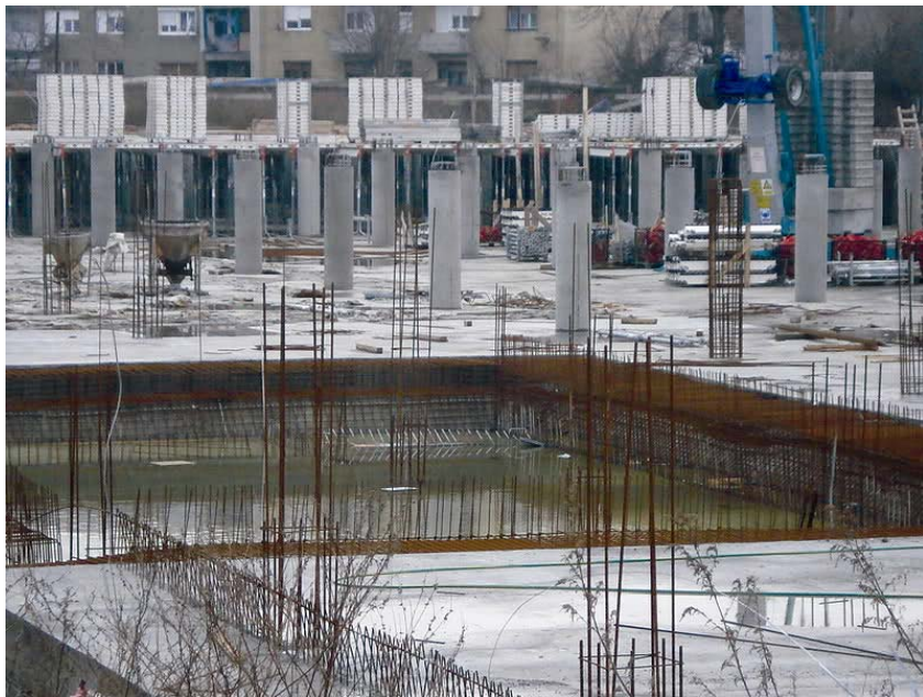
Izvedba armiranobetonskih stupova u podzemnoj garaži
