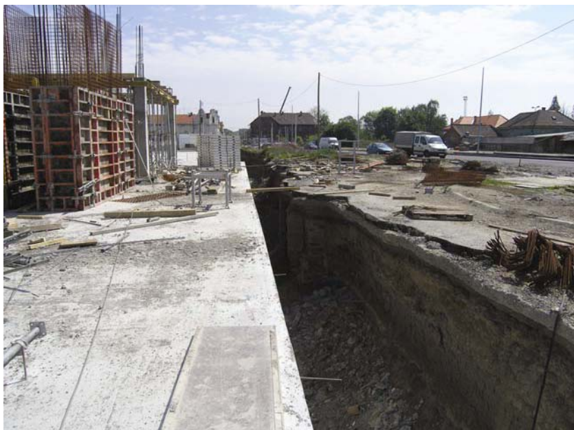
Radovi na dijelu kolodvora uz „intrazonsku cestu“
