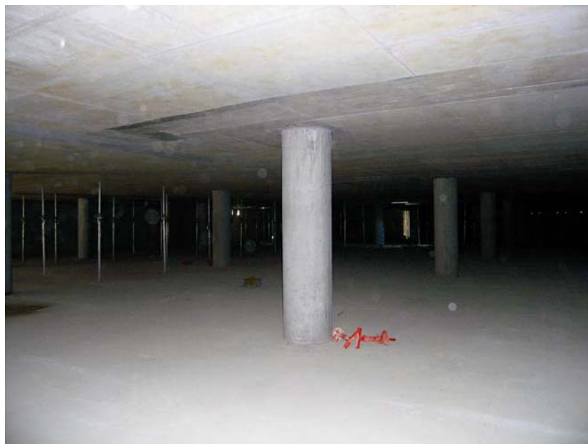
Izvedeni stupovi u podzemnoj garaži
