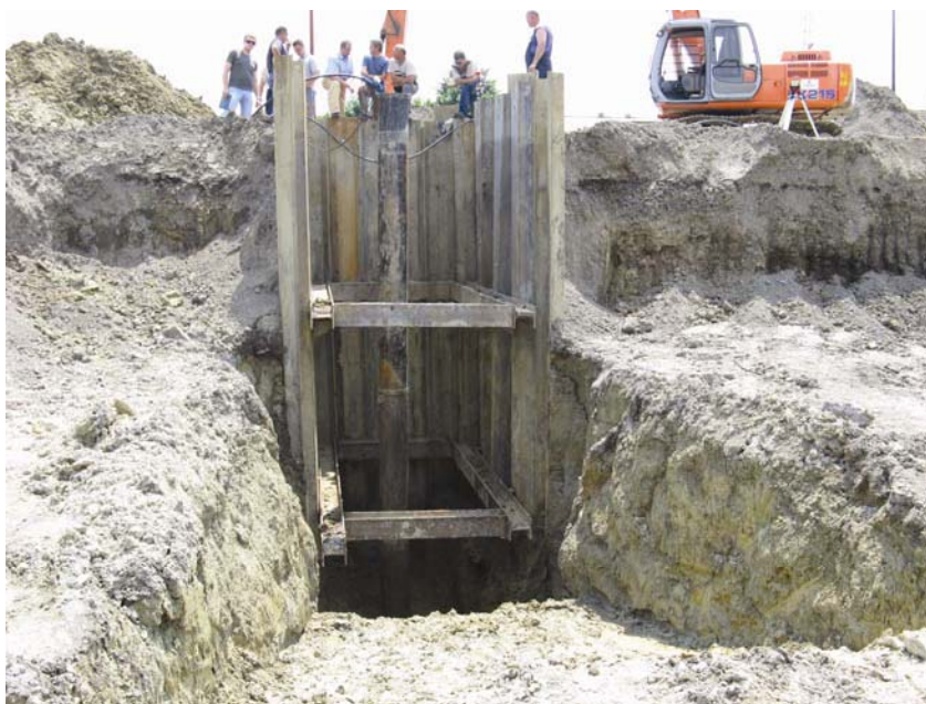
Izvedba drenaže i upojnog bunara
