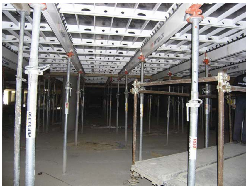
Podupore i oplata stropne ploče podzemne garaže
