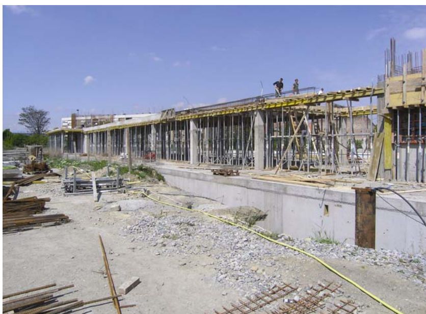
Radovi na zgradi kolodvora (pogled s jugoistoka)
