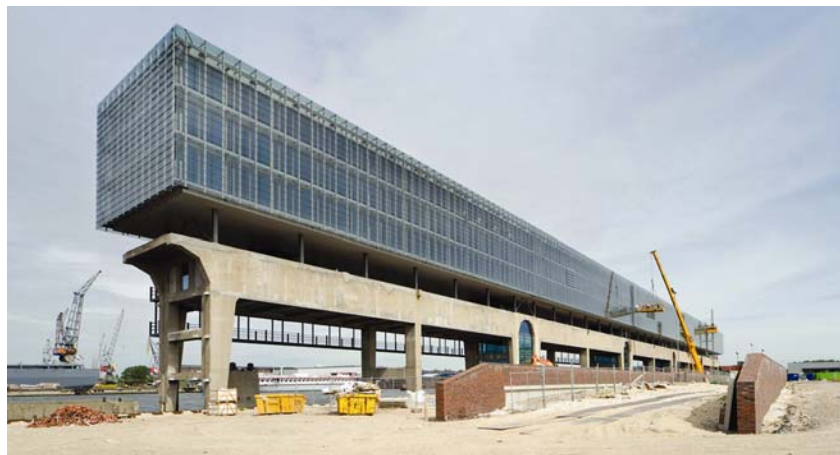
Kraanspoor pred završetkom gradnje
