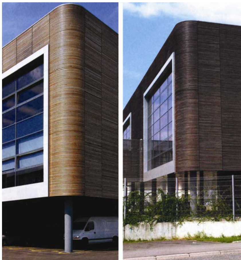
Pročeljna obloga od ariša – lijevo nakon ugradnje, desno poslije nekoliko godina kada je ariš dobio prirodnu patinu
