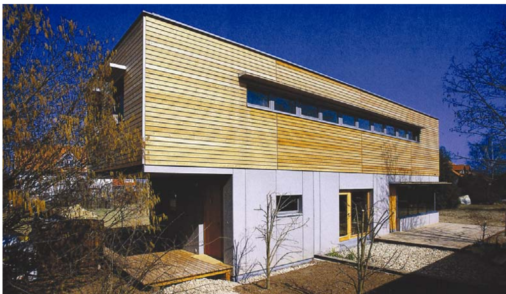
Požutjelo pročelje nakon godina izloženih sunčevu zračenju
