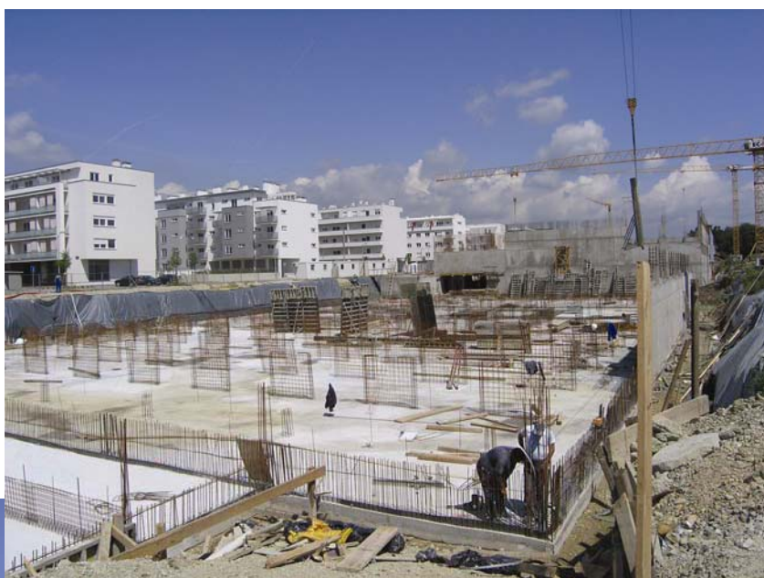
Pogled na gradilište i dio gotovih građevina
