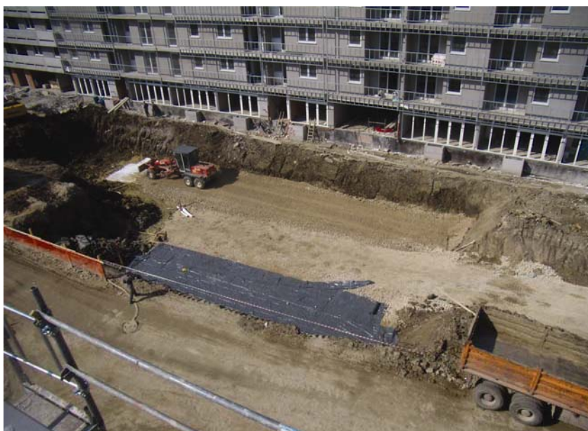
Radovi na temeljnoj ploči jedne od zgrada
