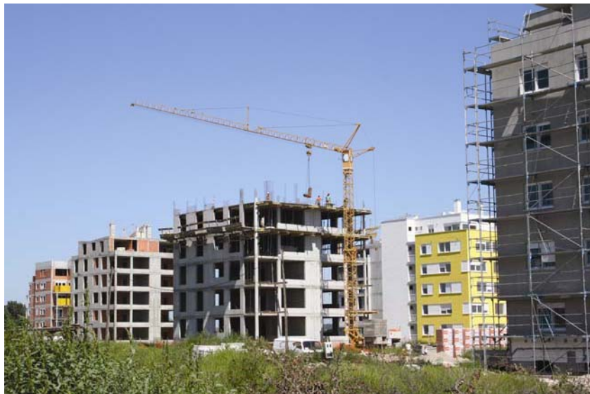
Samostojeće zgrade u izgradnji
