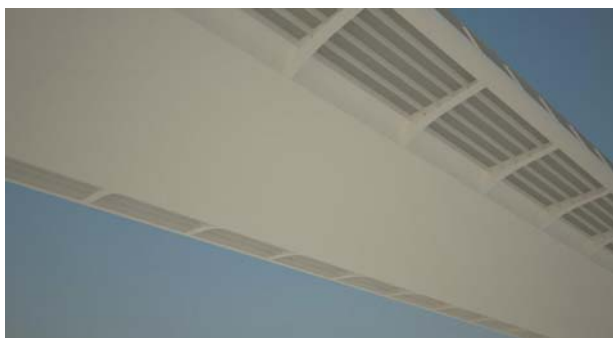
Slika 5. Podgled mosta – uzdužna rebra na konzoli
