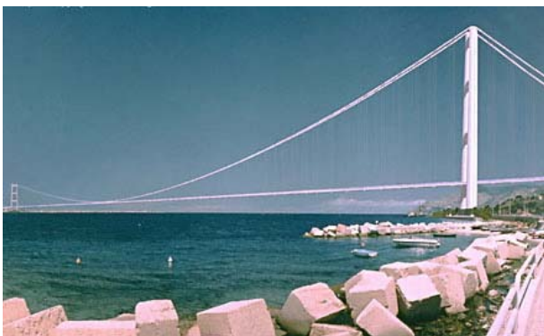
Slika 2. Idejni projekt mosta preko Messine L = 3300 m
