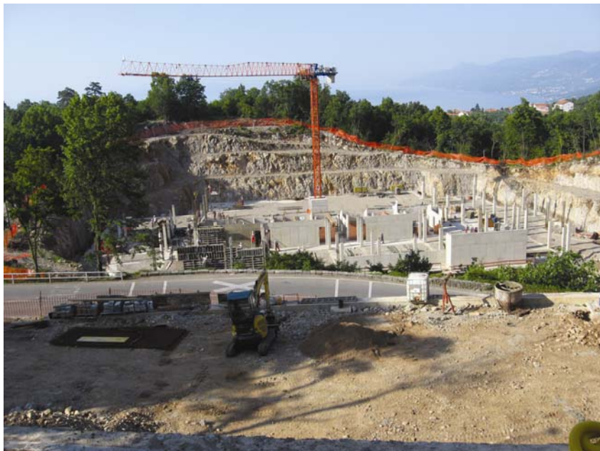
Betonski radovi na gradnji dvorane
