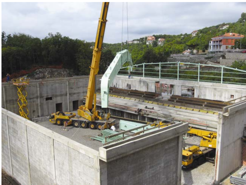
Montaža čeličnih nosača
