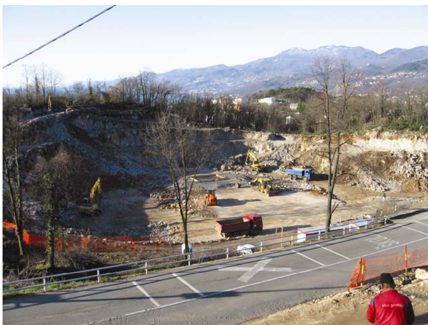
Zemljani radovi na gradilištu dvorane
