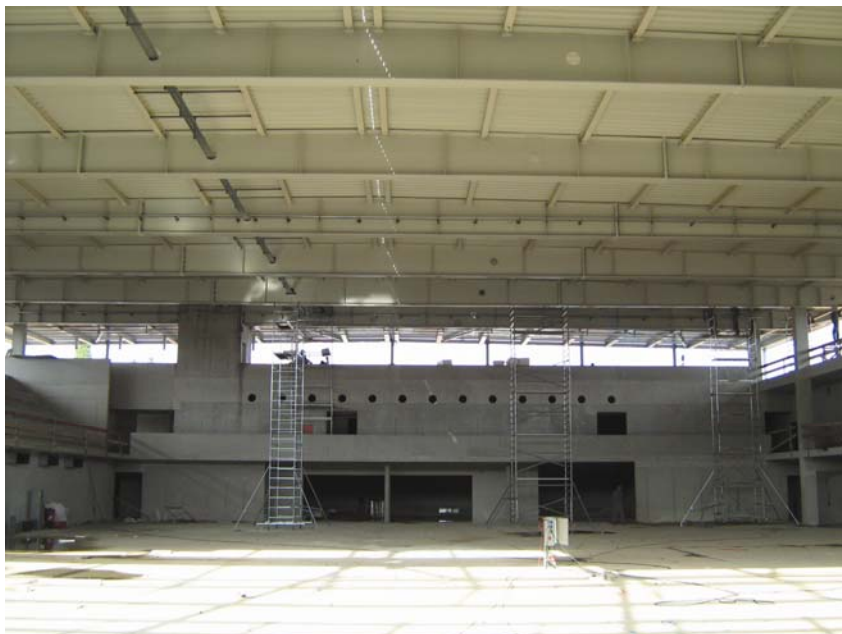
Unutrašnjost dvorane i montirana čelična konstrukcija
