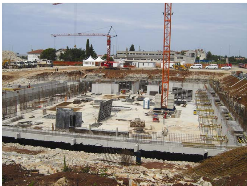
Početak betonskih radova na dvorani u Novigradu
