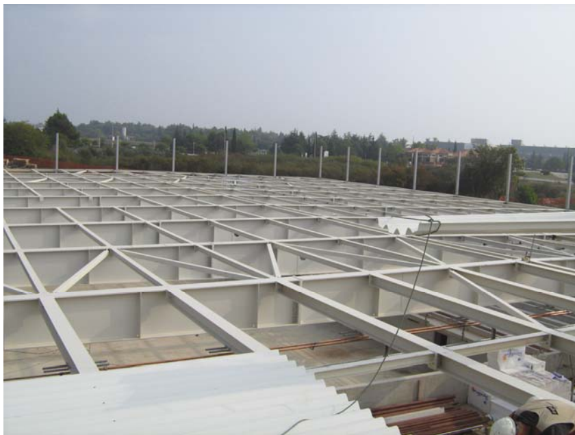
Montaža krovne konstrukcije na dvorani
