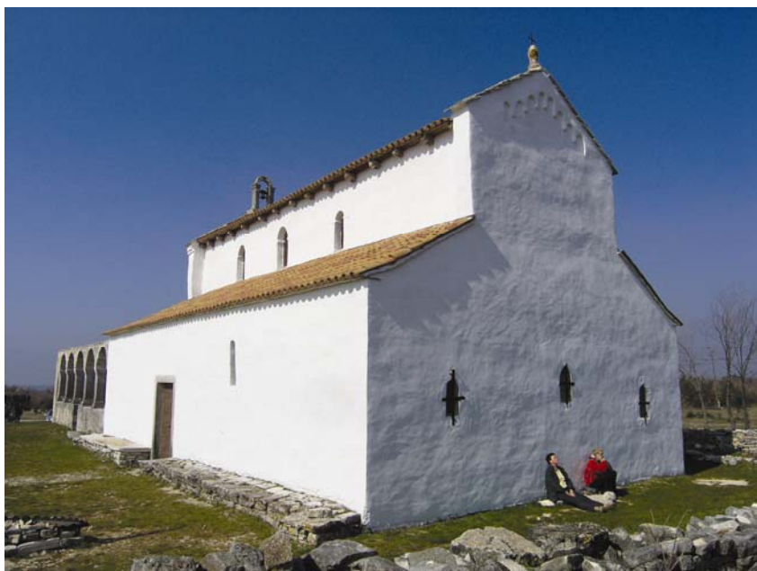
Začelje restaurirane crkve Sv. Foške u Batvačima
