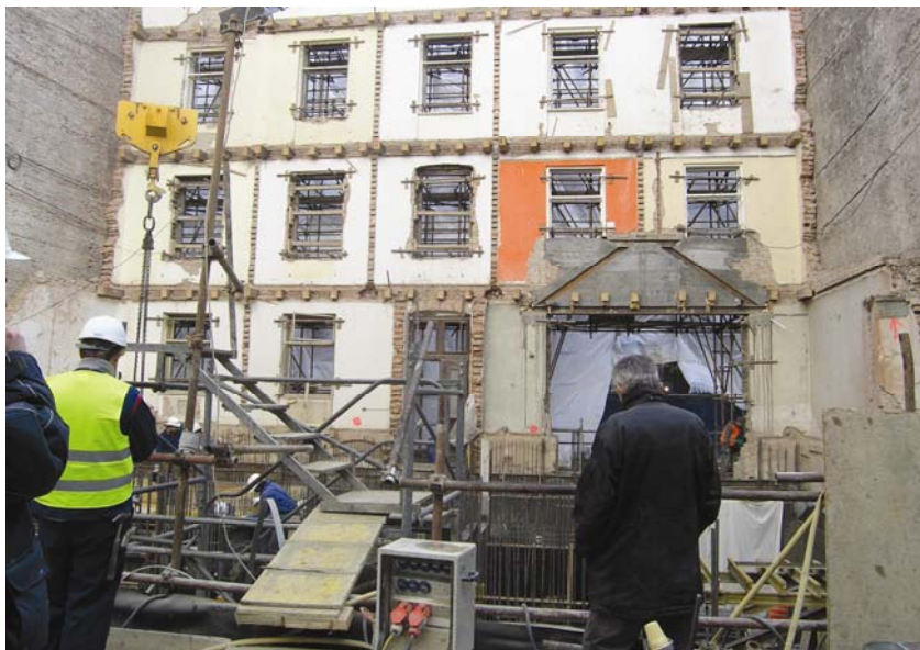
Unutrašnja strana sačuvanog pročelja zgrade Varšavska 6
