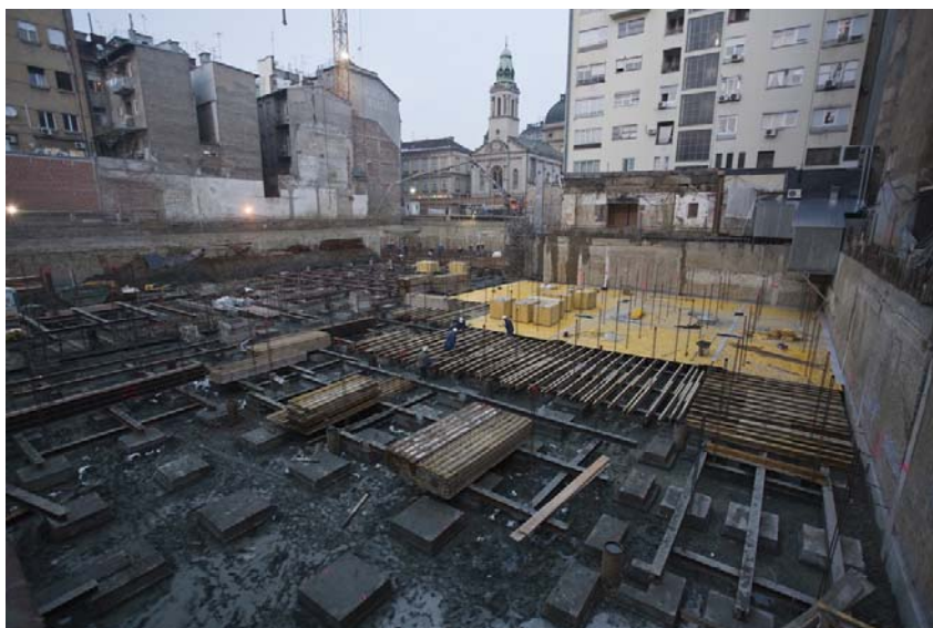
Postavljanje oplata prve armiranobetonske ploče na privremenim temeljima
