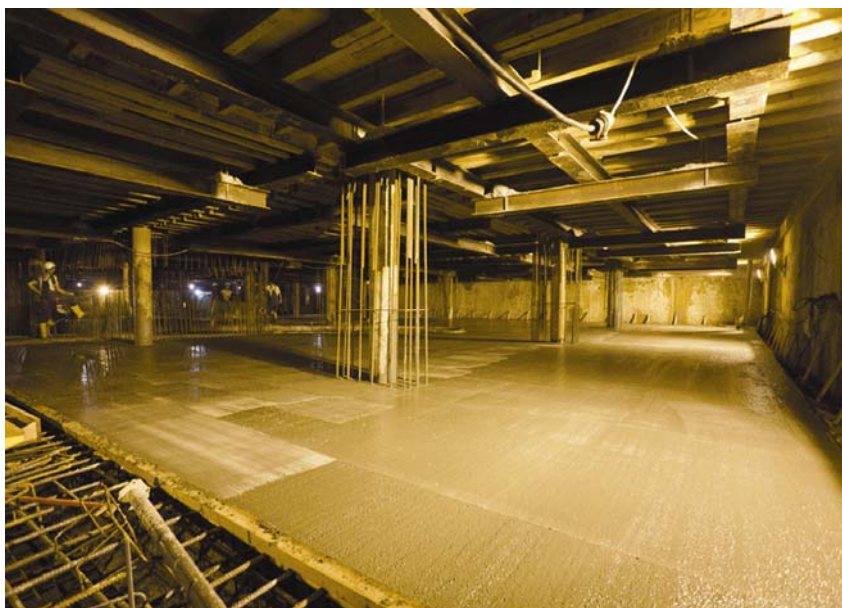
Betoniranje temeljne ploče
