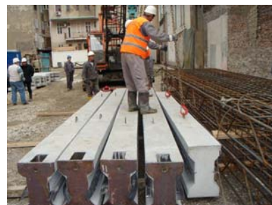
Spojni elementi dijafragme i armaturni koševi
