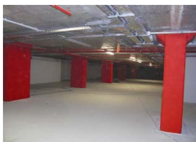
Završeni radovi u garažnom prostoru tijekom posjeta
