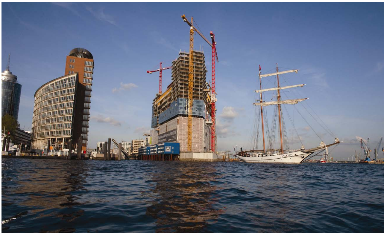
Pogled na građevinu u gradnji
