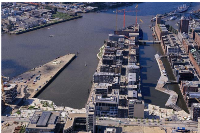
Dio hamburške luke na kojem se nalazi gradilište
