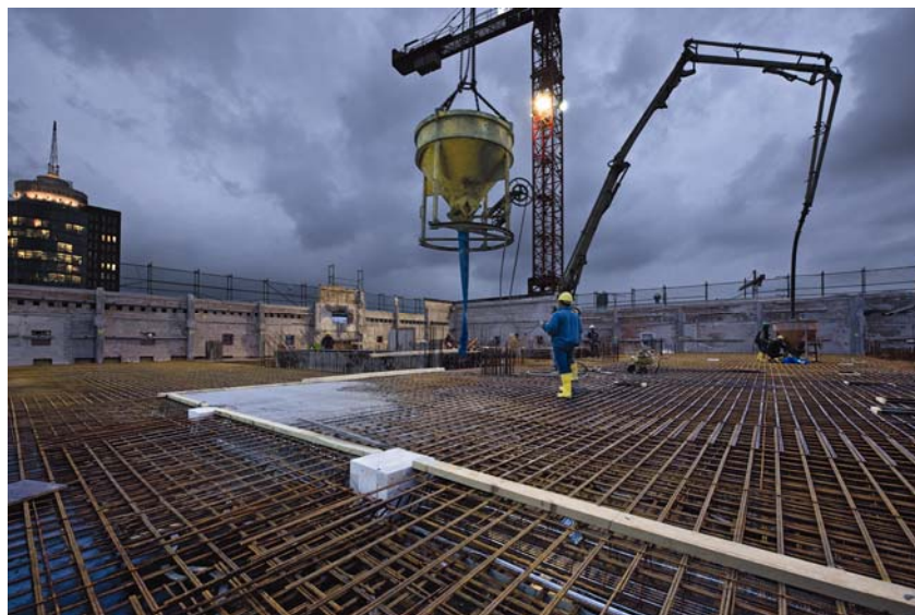
Početak betoniranja jedne ploče
