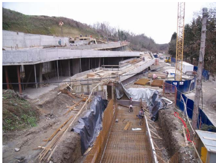
Radovi na glavnoj zgradi
