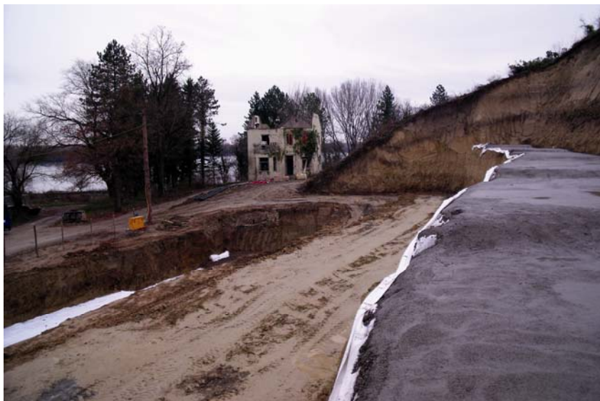
Dio gradilišta na početku radova ( u pozadini ostaci vile Streim)
