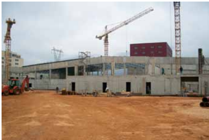
Izvedba armiranobetonske konstrukcije bazena
