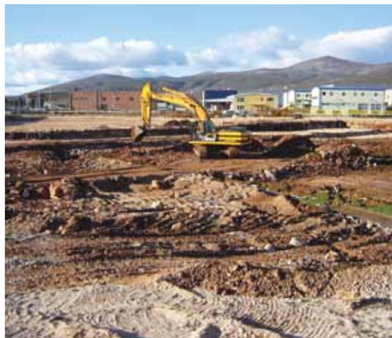
Početak radova na gradnji športskog kompleksa
