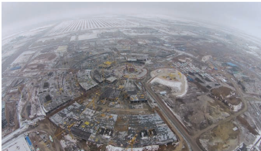
Pogled na gradilište
