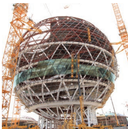
Gradilište Kazaškog paviljona
