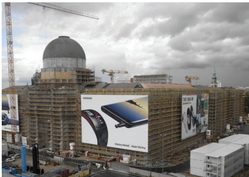
Gradilište Gradskog dvorca snimljeno u rujnu 2017.
