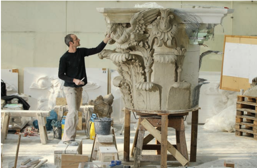
Rekonstrukcija elementa fasade
