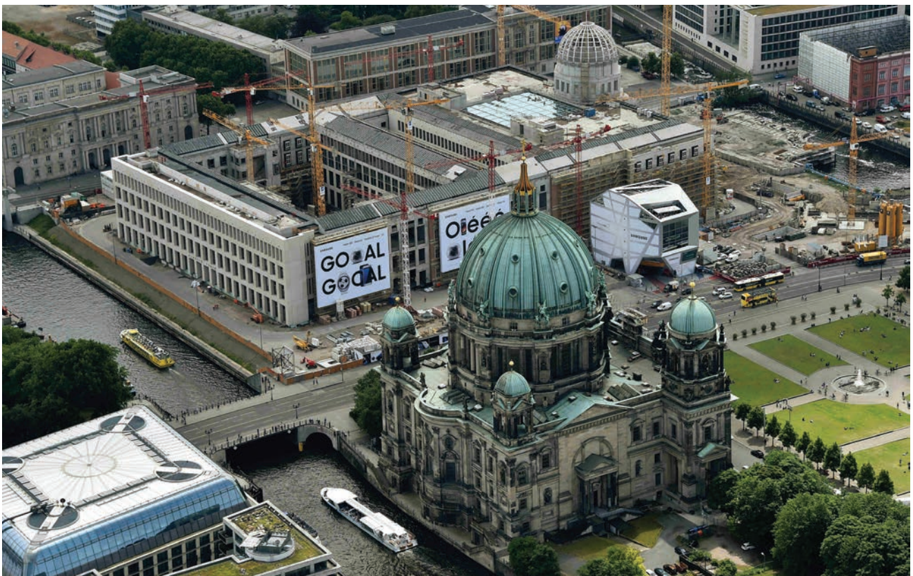
Detalj s gradilišta
