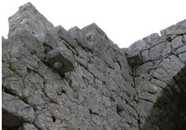
Slika 12. Kamene perforirane konzole – nosači drvene ograde
