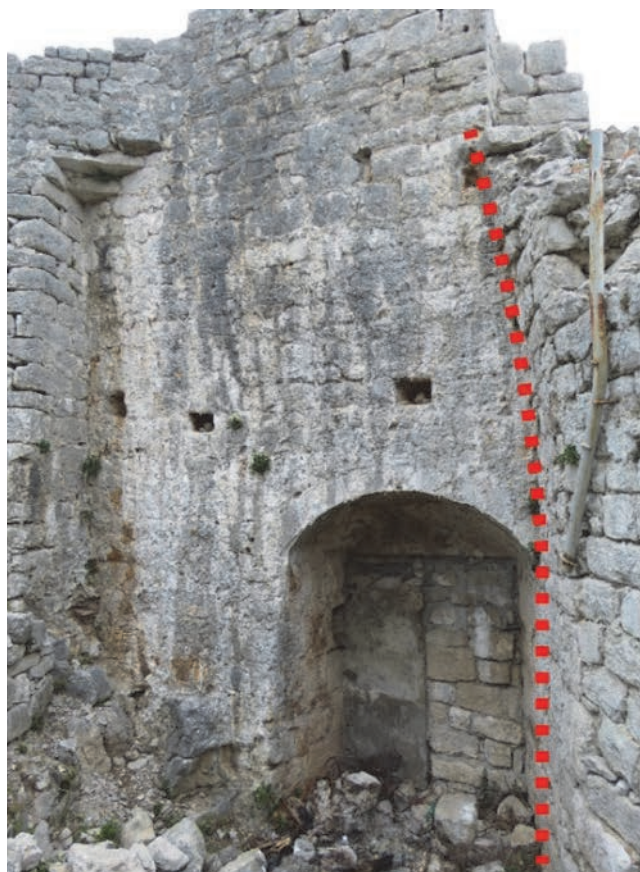
Slika 14. Konzolno izbačeni nadozid obrambenog zida uz donžon i jugoistočnu kulu
