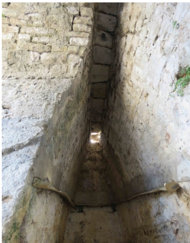
Slika 19. Lažni svod u jugozapadnoj kuli
