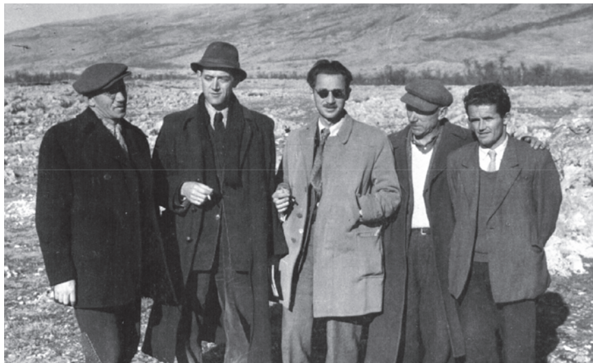
Stručnjaci Elektroprojekta (ing. Pavlin, ing. Žugaj i ing. Čalogović) na izgradnji brane Peruća
