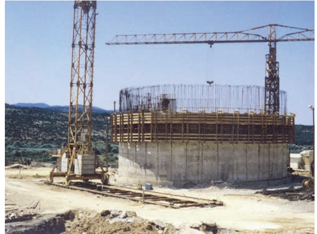
Spuštanje bunara strojarnice
