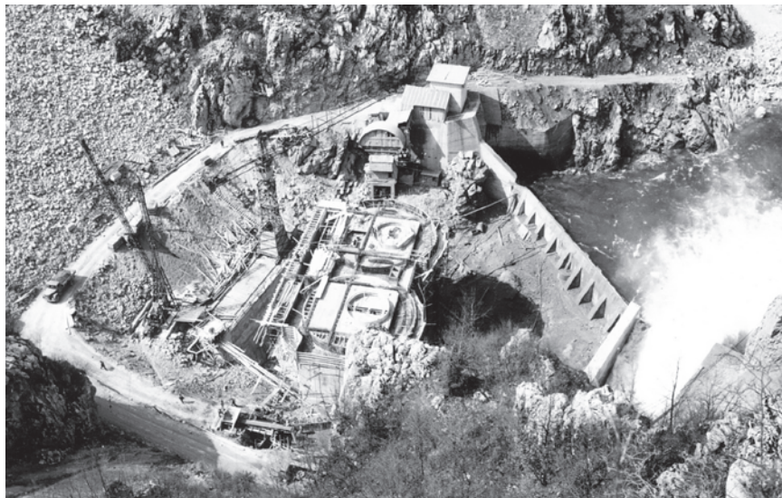
HE Sklope – izgradnja
