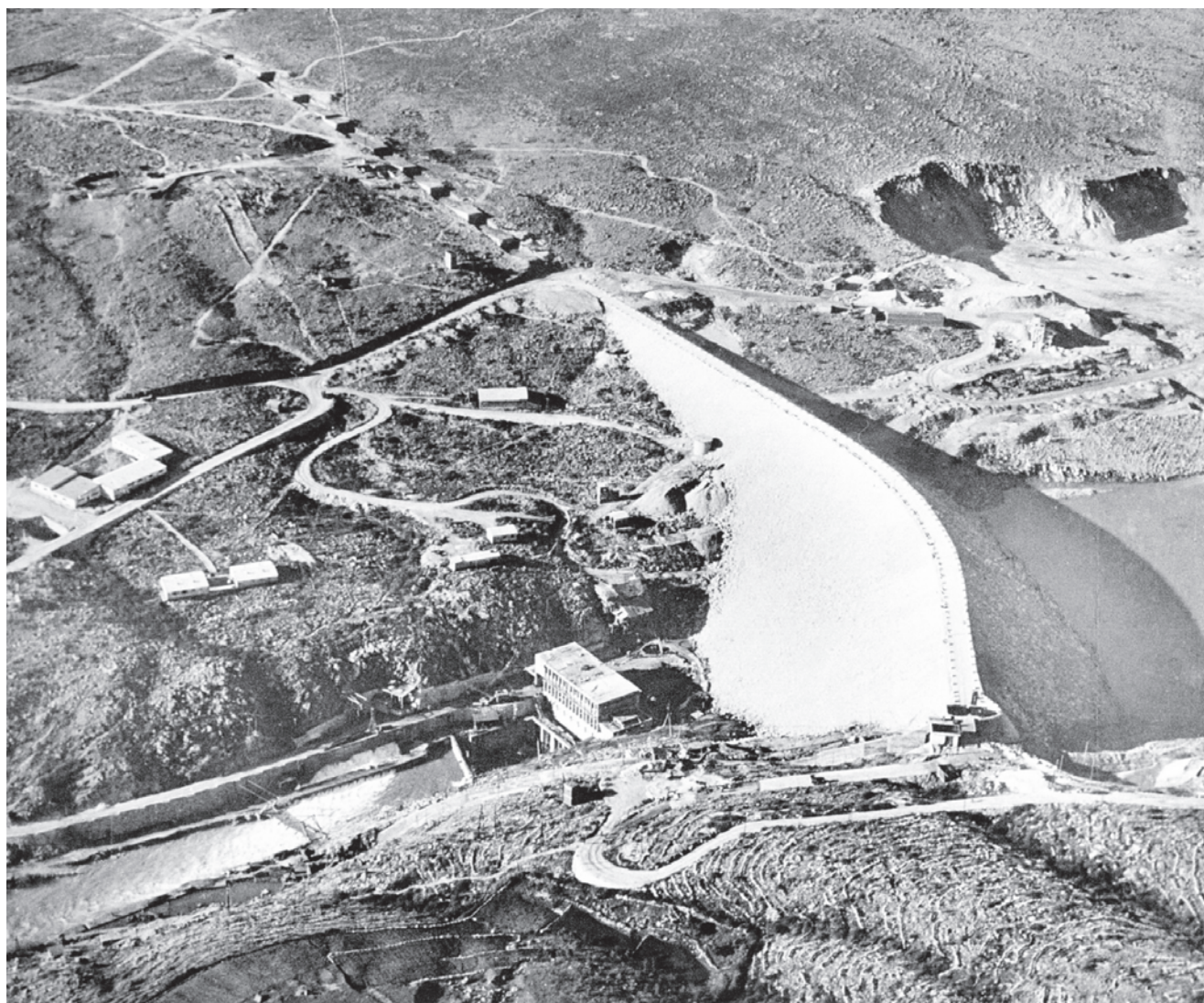
Izgradnja brane Peruća
