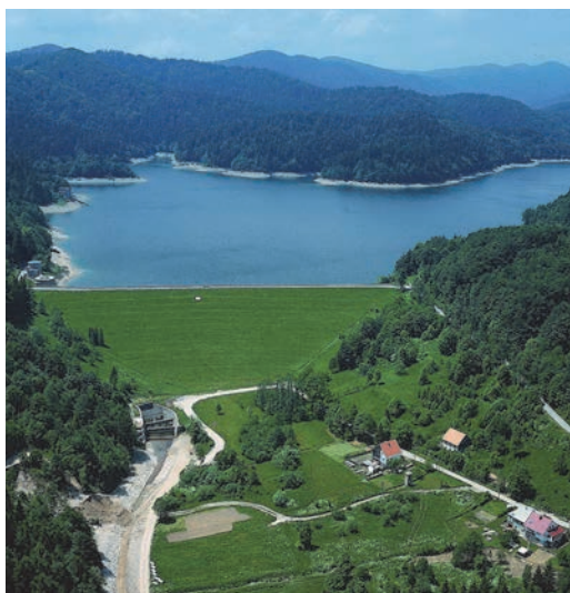
Akumulacija i brana Lokvarka i strojarnica HE-a Vinodol
