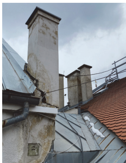
Teška oštećenja dijelova dimnjaka i zabatnog tavanog zida
