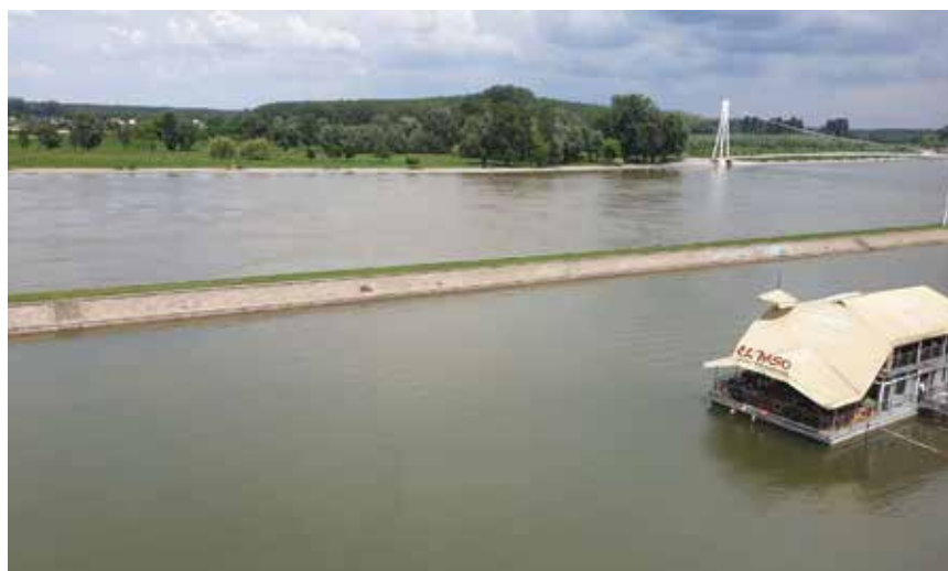
Radovima na izgradnji dodatnih vodenih tokova povećat će se otpornost obrane od poplava
